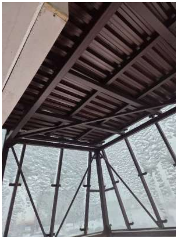
Фото №2. Металлический каркас навеса
